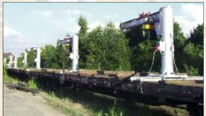
Neun 0,5 t Säulenschwenkkrane auf Spezialrahmen, synchron betrieben mit Zentralfunkfernsteuerung für die Montage von 30 m langen Gleisschienen.
